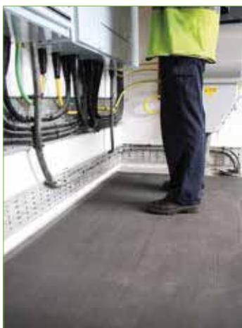
Tappeto leggero isolante per il lavoro sotto tensione elettrica. Progettato per l'uso di fronte a quadri elettrici e apparecchiature ad alta tensione, per la sicurezza degli operatori contro le scosse elettriche.
